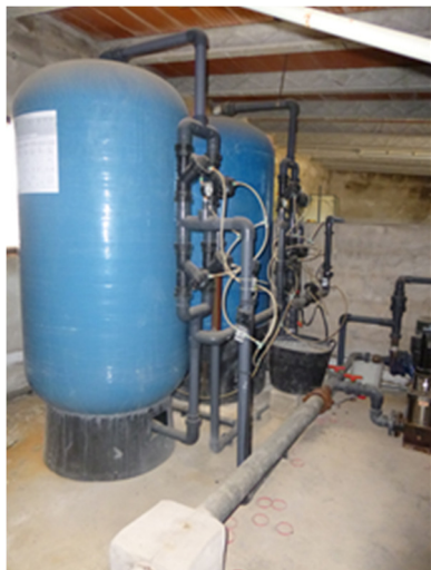
Equipos filtración ETAP Pozo Cremaes y reelevadora ETAP Pozo Cremaes
