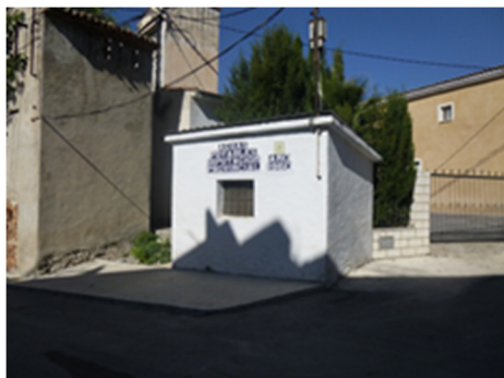
Caseta Pozo Fuentes
